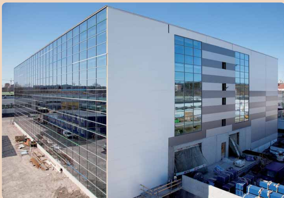
Außenansicht der vergrößerten Produktionsstätte mit großer Glasfassade. (Foto: Planmeca, Finnland)
