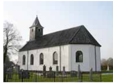
De Hervormde Kerk is één van de meest karakteristieke gebouwen van Gasselte.
