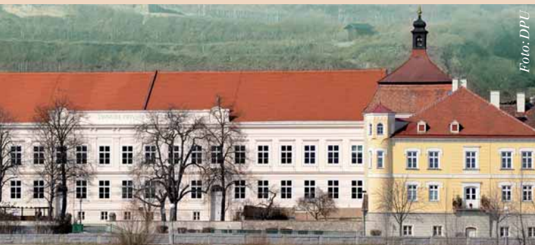
Das ehemalige Hauptschulgebäude ist der künftige Sitz der DPU.
