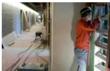
Studenten klussen in voormalig ACTA-gebouw. (foto: RTVNH)
