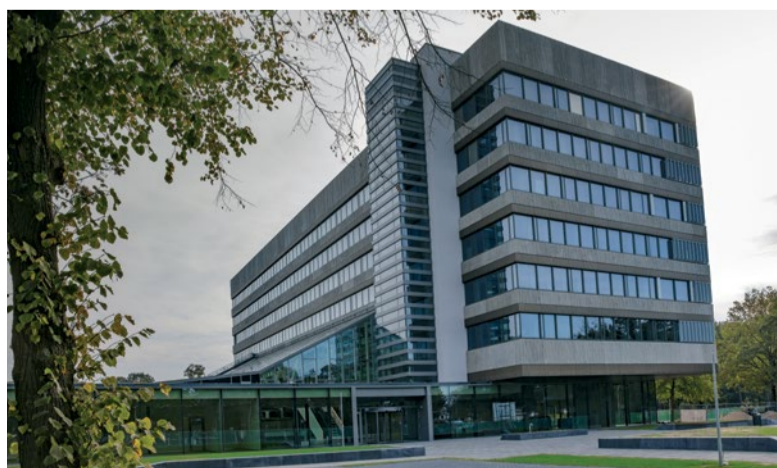
De afdeling tandheelkunde van het Radboudumc in Nijmegen.
