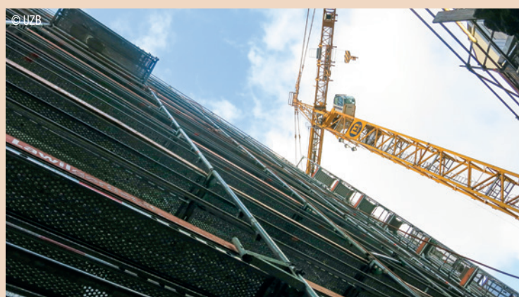
Der Neubau der UZB kommt termingerecht voran.
