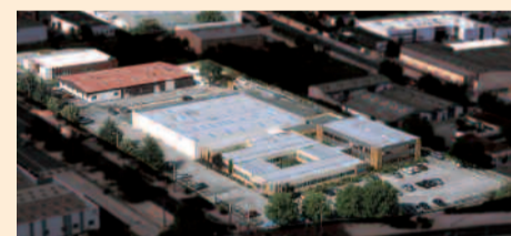
Vue aérienne du siège social à Mérignac
