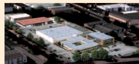
Vue aérienne du siège social à Mérignac
