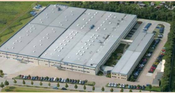
Luftansicht der VOCO Firmenzentrale in Cuxhaven.
