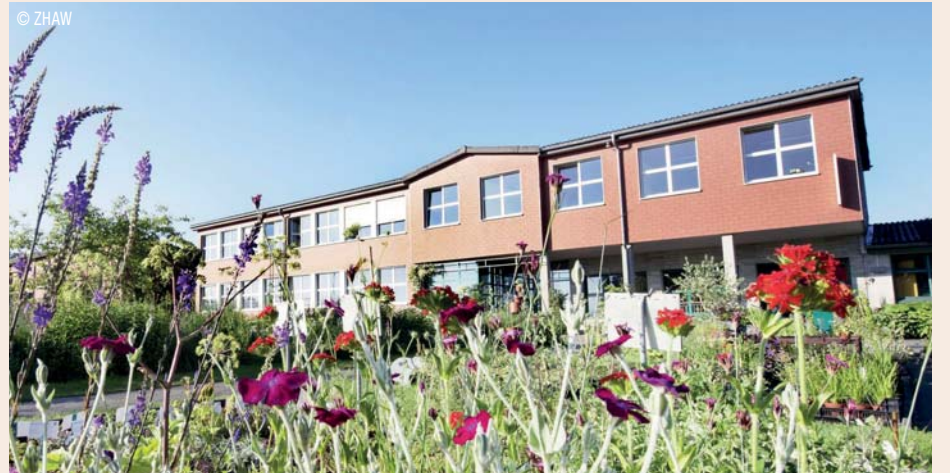
Wädenswil – Campus Grüental, Departement Life Sciences und Facility Management.
