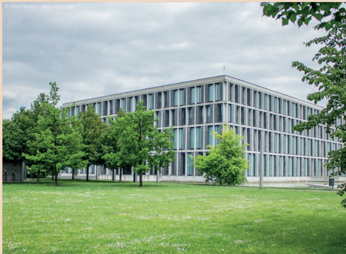
Bundesarbeitsgericht in Erfurt.
